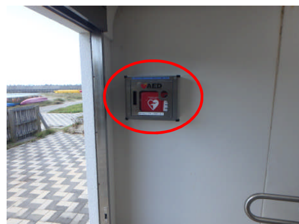
脇浜なぎさ公園トイレ(車いす用トイレ内)
