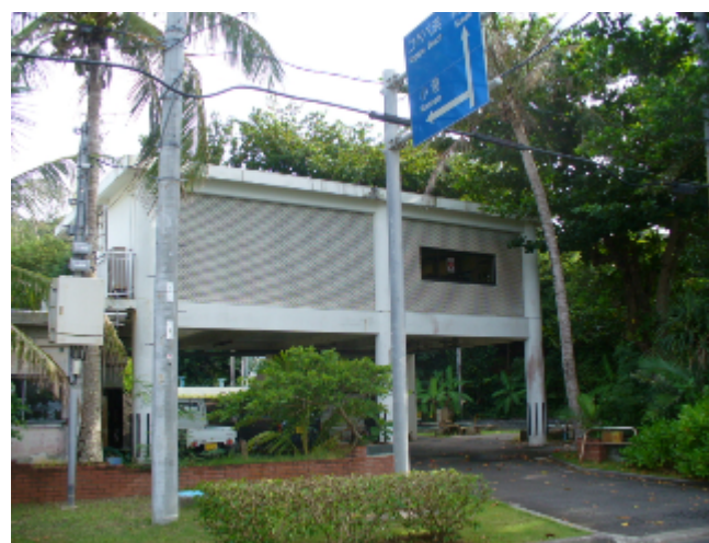
扇浦浄水場(扇浦レストハウス前) 2階事務室にAED設置
