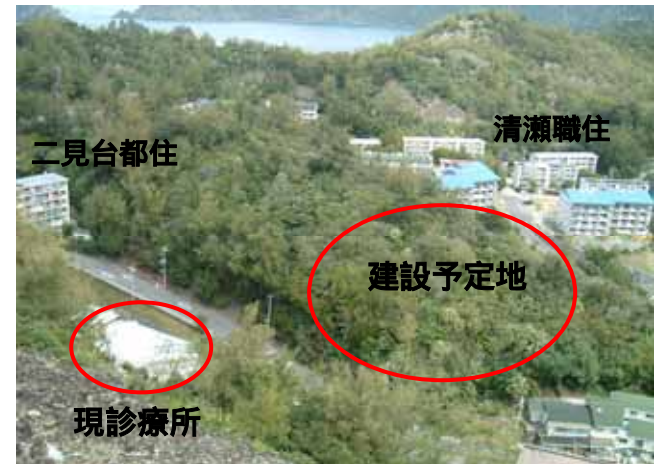
〔建設予定地写真〕
