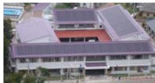
屋根に設置されている太陽光発電パネル
