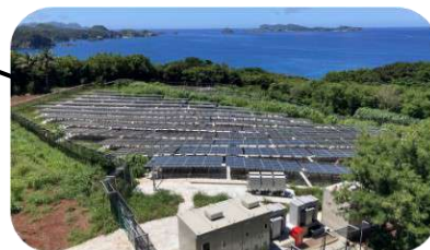
御幸之浜太陽光発電所
