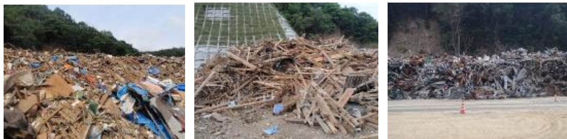
図 4-2 津波被害現場での分別集積(左:混合廃棄物、中:木くず、右:金属くず)
