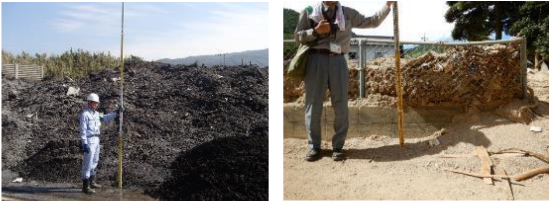
図 4-4 土砂災害における堆積量の現場調査風景 左:大島土砂災害、右:西日本豪雨(広島県)
