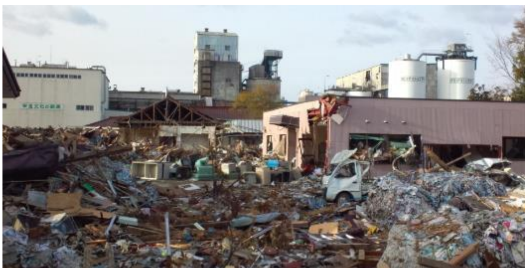
図 4-1 津波被害状況(東日本大震災)
