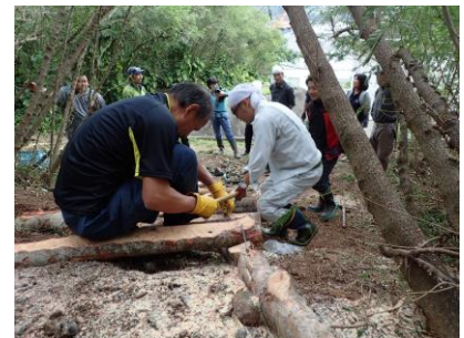
かすがいで木枠を固定
