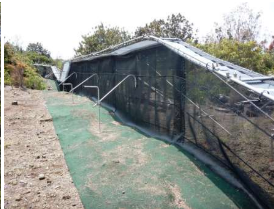
アノール侵入防止柵設置状況(Cライン)
