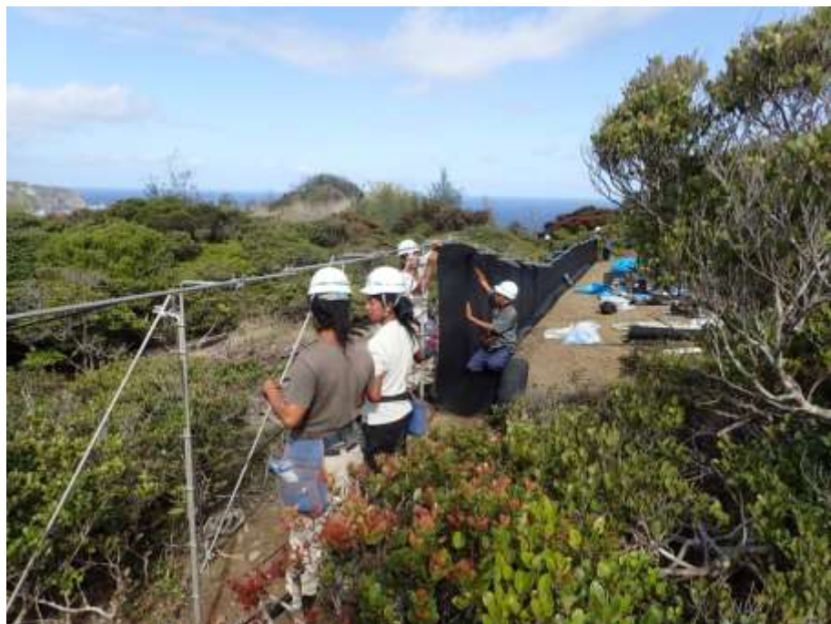
施工状況(Cライン)
