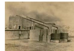
レモングラスオイルの工場。硫黄が原の噴火口から出る蒸気の熱を利用してレモングラスを蒸留し、精油を精製していた
