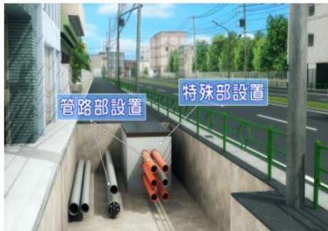
電線共同溝本体工事
