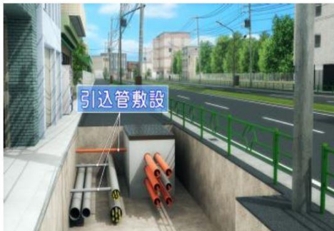
ケーブルの入線と 引込管工事
